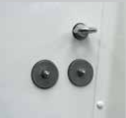
Beanspruchte Bauteile werden mit einer Gummi- und Edelstahlplatte verstärkt
